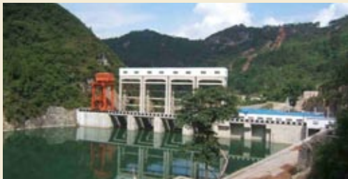
本行重庆黔江分行支持少数民族地区建设项目 --- 黔州舟白电站全景
