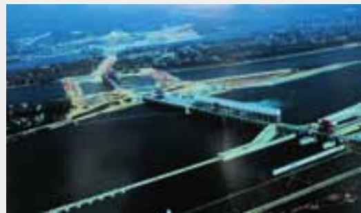
本行广西分行信贷支持的长洲水利枢纽项目
