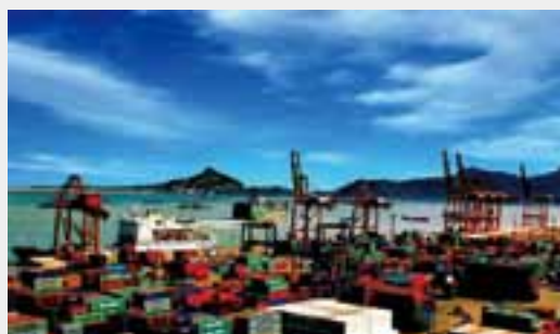
本行江苏分行信贷支持的连云港港口建设项目
